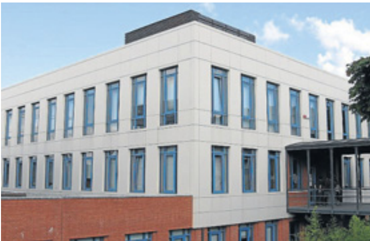
Oficina Nextel Bilbao. FOTO: NEXTEL S.A.
