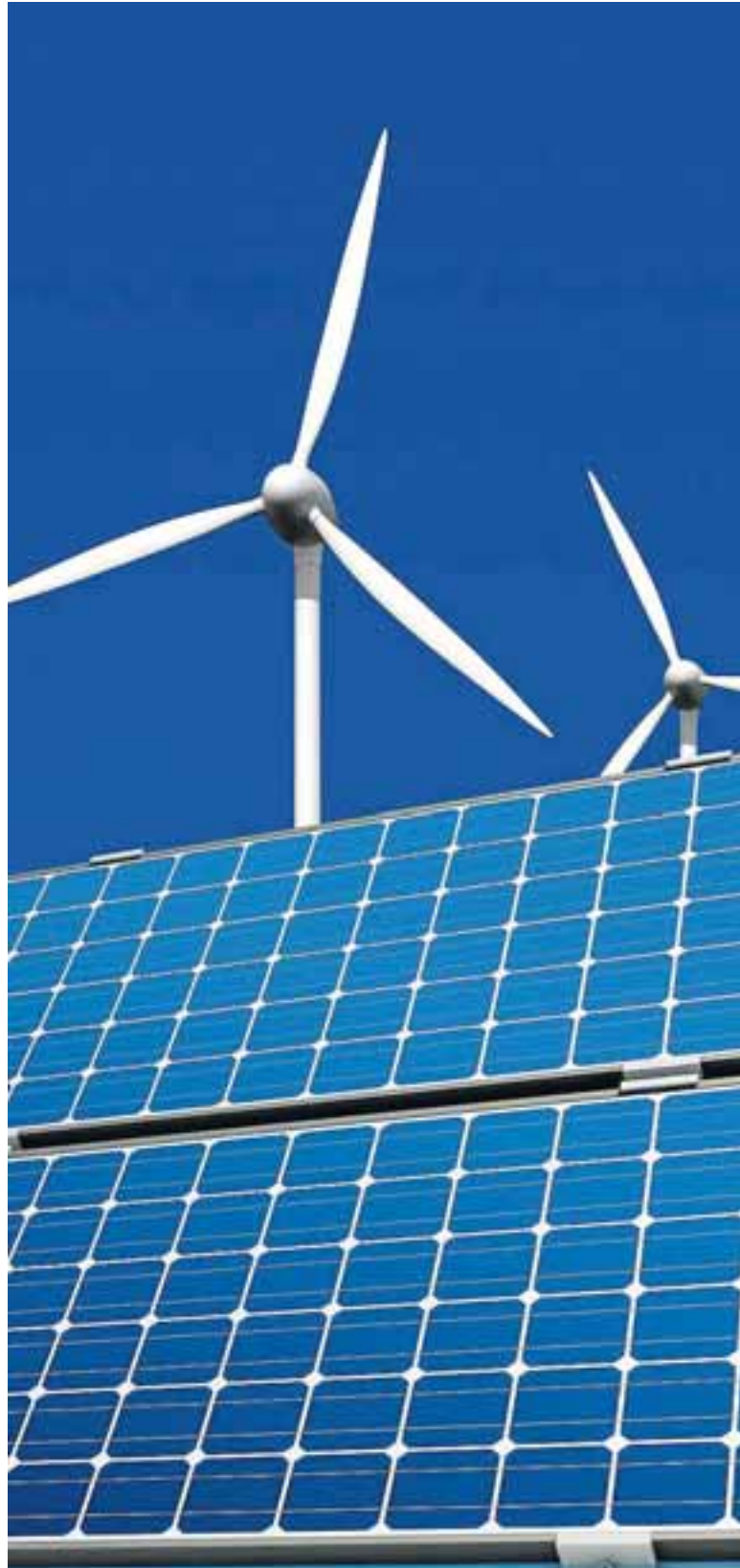
Instalación para aprovechamiento de las energías solar y eólica. FOTO: DEIA
